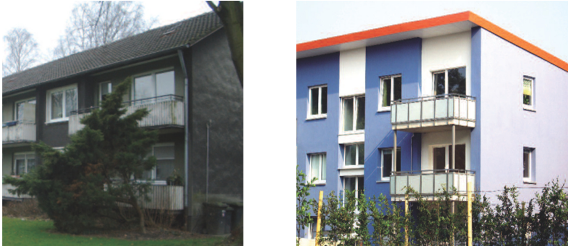
Abbildung 30 Ausgeführte Dachaufstockung links vorher, rechts nachher [Quelle: VBW Bauen und Wohnen GmbH, Bochum]
