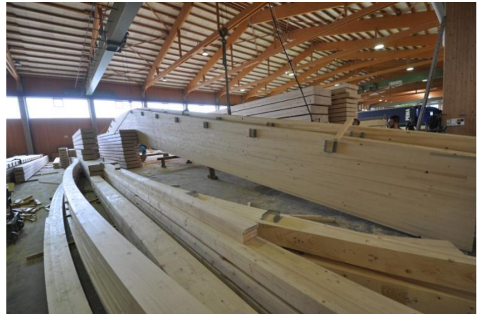
16 Brettschichtholzträger mit Montage von Anschlussbauteilen
