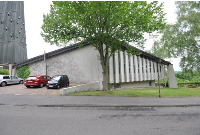
7 Ansicht von außen mit einem Auflager rechts im Bild
