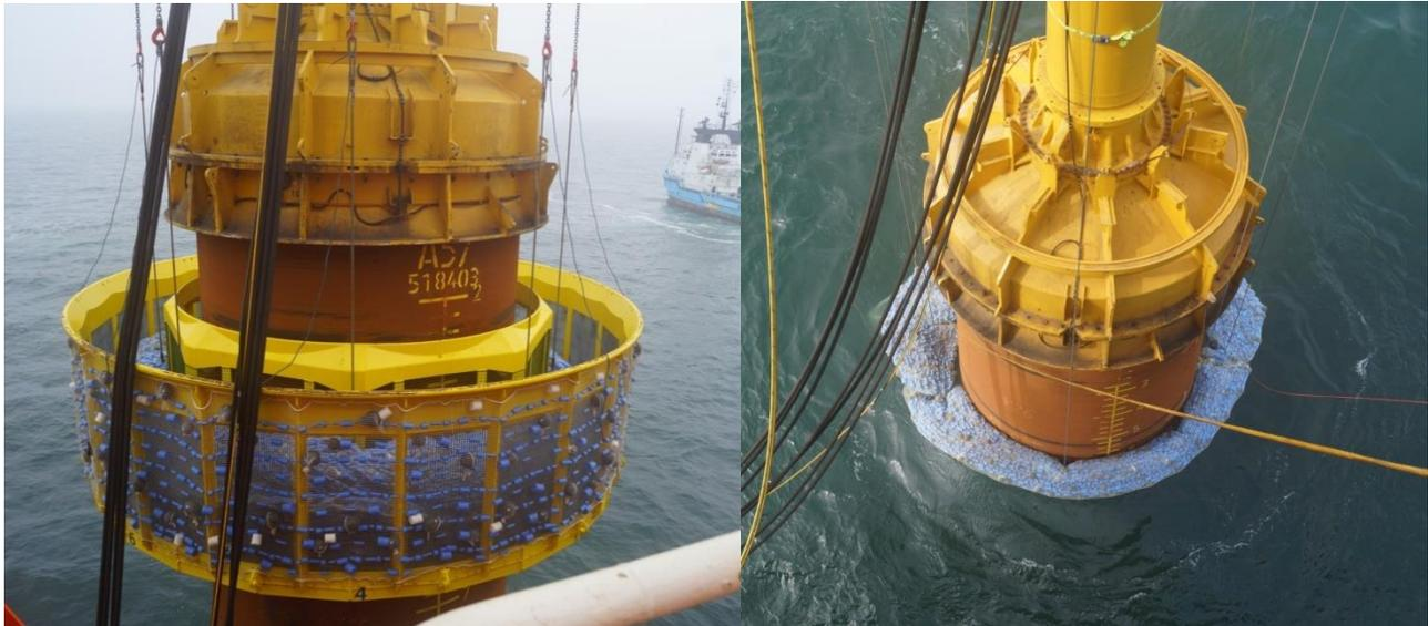
**Abbildung 20: Einsatz des HSD-Systems beim OWP Amrumbank West [Bruns et al., 2014]**
