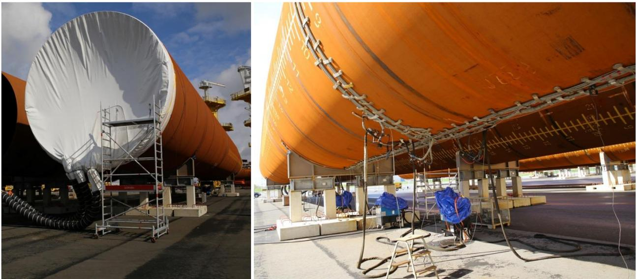
Abbildung 35: Verschluss des Monopfahles am Fuß mit Einlass für die Ölheizung (links) und Induktionsheizung (rechts)
