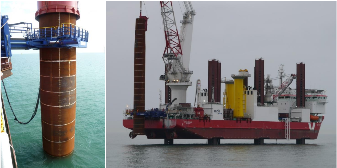
Abbildung 38: Pile-Gripper zur Führung der Monopfähle (links) und Errichterschiff beim Einfädeln eines Pfahles in den Pile-Gripper (rechts)
