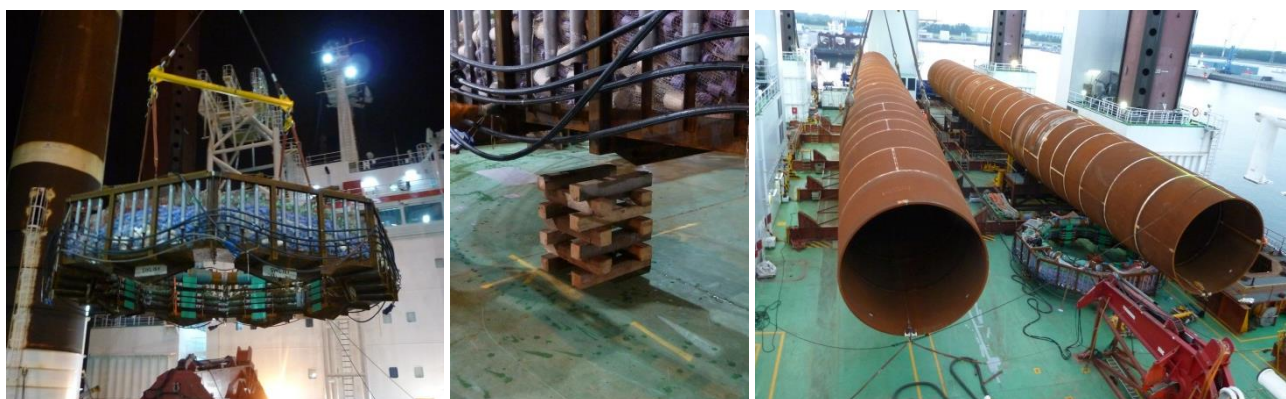
Abbildung 46: Verladen des HSD-System an Deck des Installationsschiffes (links), Auflagerpunkte (Mitte), geringer Platzbedarf unterhalb der Monopfähle (rechts)
