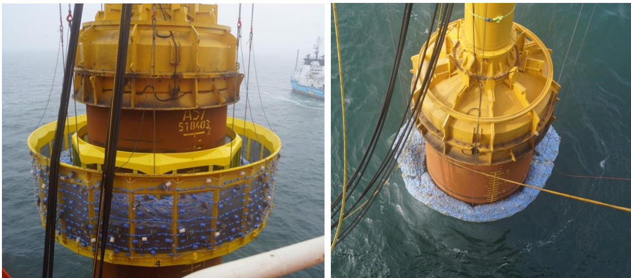
Abbildung 59: Einsatz des HSD-Systems beim OWP Amrumbank West [Bruns et al., 2014]
