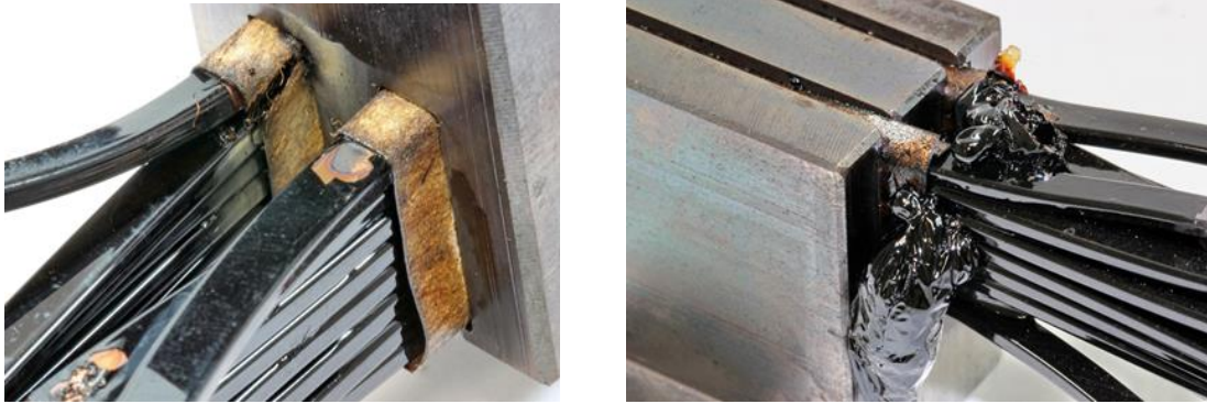
Elektrisch bedingter Durchschlag am Nutausgang (links) und thermisch bedingter Ausfall (rechts)
