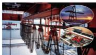
Berührungslose Energieübertragung (2 x 25 kW Containerkran, Virginia USA). TU Braunschweig - IMAB
