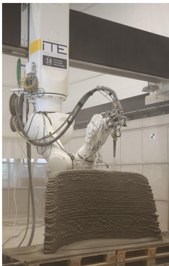
Robotische Fertigung eines Wandelements mittels SC3DP. © ITE
