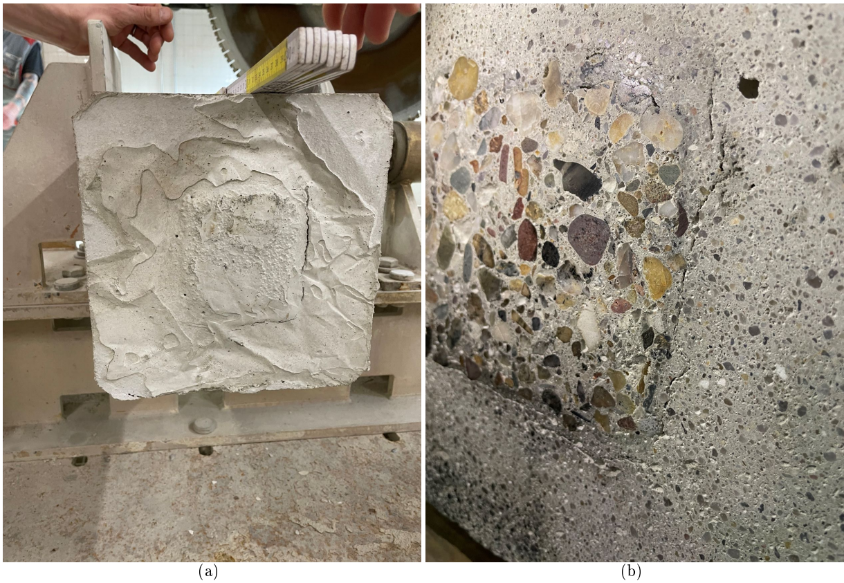
Abbildung B.16: (a) Ablösung des RM.3 Mörtels vom A4 Altbeton vor und (b) nach dem Schleifen der Unterseite
