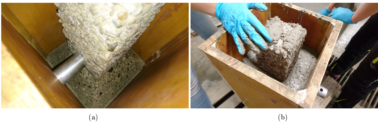
Abbildung B.10: (a) Blick in die Schalung vor (b) und während der Betonage des Betonersatzes
